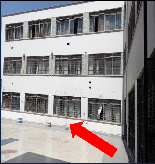
multicancha ventanas colindantes a dependencias de la sala de colección
