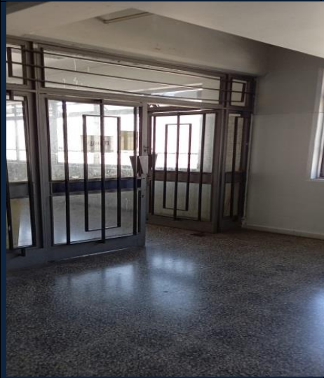
pasillo de entrada a la sala
